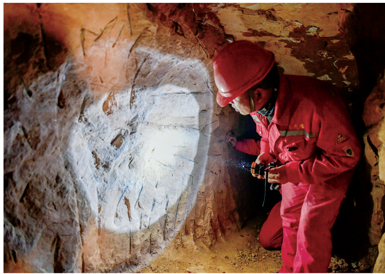
定向爆破封堵前,专业工程技术人员对盗洞进行全面检查。
