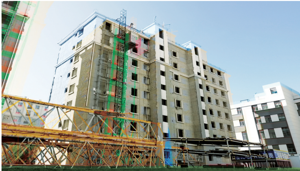
银丰保障性住房改建现场。
