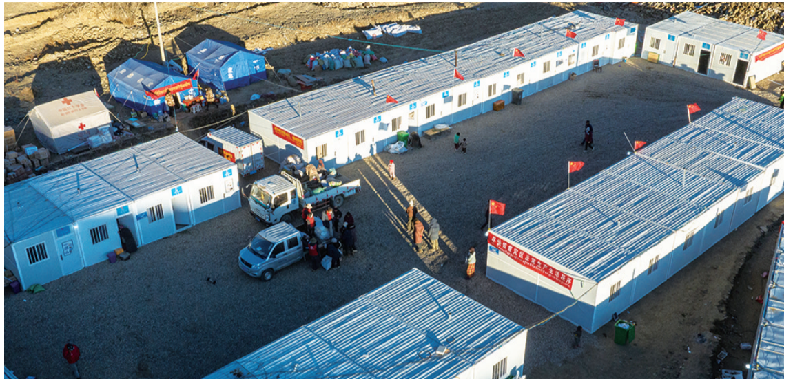
1月13日,在定日县长所乡古荣村,受灾群众正在搬进板房。本版图片均为新华社发
