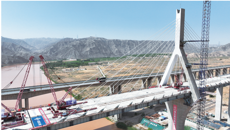
主梁采用双边工字形钢混组合梁。
