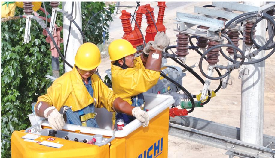
7月16日，国网石嘴山供电公司带电作业人员冒着高温“烤”验，在110千伏隆湖变523隆碳线27号杆接隔离开关上引线，实现作业期间客户“零感知”、用电“零影响”，保障电网安全稳定运行，守护万家清凉。孙帅 摄
