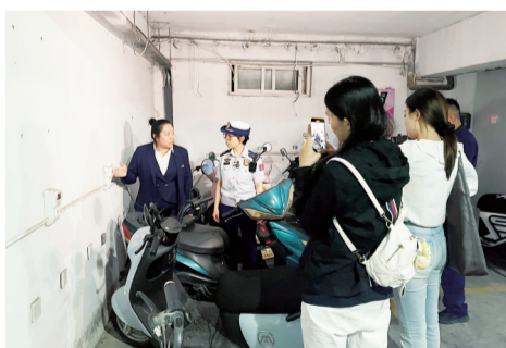
防火监督员对车棚充电设施进行检查。
