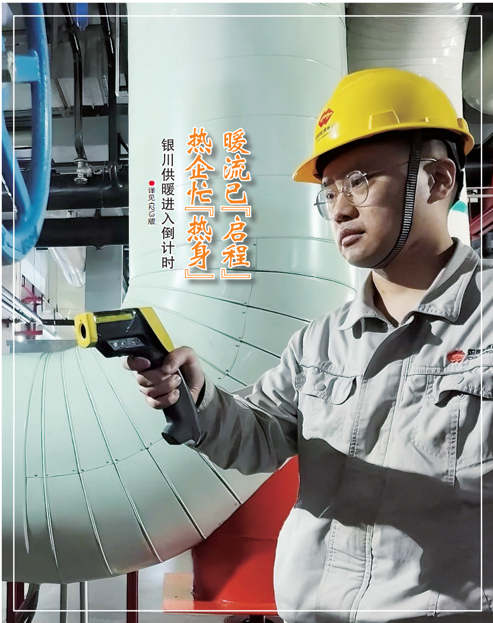
国能宁夏灵武发电有限公司工作人员巡查供热管道。受访单位供图
