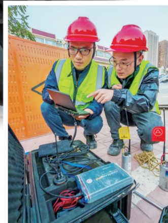
热企工作人员定位地下管线漏水点。
