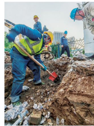
维修人员抢修供热管道。
