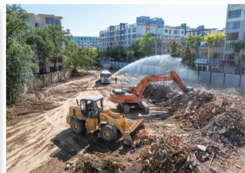
城中村改造现场。
