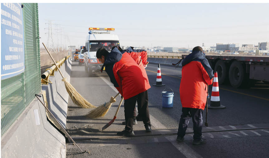
养护工人坚守国省干线公路。
