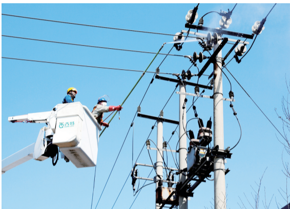
带电清污 护航春检
